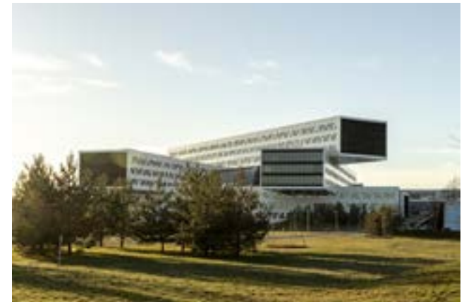
Equinor-bygget. Kilde: Bærumshistorie.no
