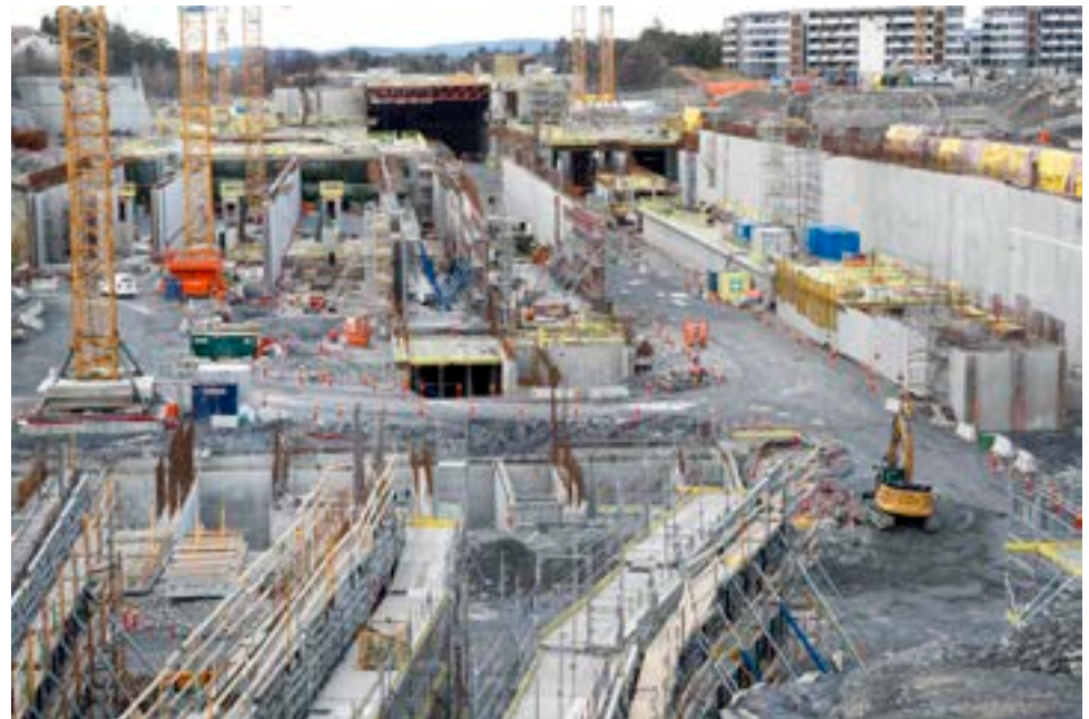
Byggegroppa sett fra bensinstasjonen, mellom Fornebu S og Rolfsbukta. Neppe noen gang, noe sted i Norge har det vært en byggegrop med slike dimensjoner. For de reisende er det kun det lille arealet til høyre i bildet hvor perrongen er, som når banen står ferdig, blir synlig. Alt annet er for service og vedlikehold. Det mørke feltet bakerst i bildet er verkstedet.
