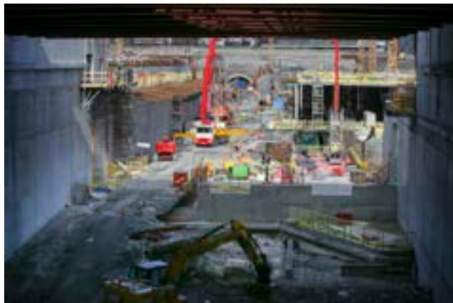
Verkstedet på Fornebu stasjon, tatt i retning Lysaker
