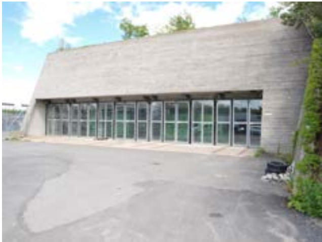
Avfallssuget. Foto: Bærum kommune
